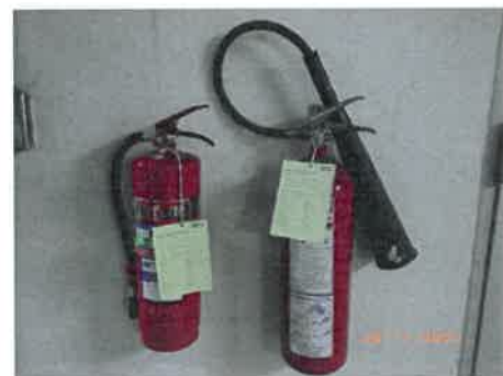
ถังดับเพลิงแบบผงเคมีแห้ง
