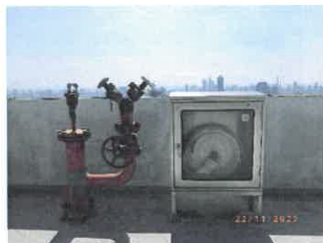
ตู้เก็บสายส่งน้ำดับเพลิง
